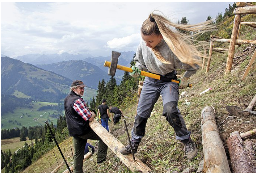
Installation von Ogiböcken: Dank dem engagierten Einsatz der Sekundarklasse 3B aus Embrach ZH wird an diesem Steilhang schon bald ein Schutzwald spriessen. Fotos: Roger Wehrli
