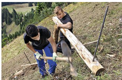
Die Arbeit im steilen Gelände erfordert Kraft und Ausdauer.
