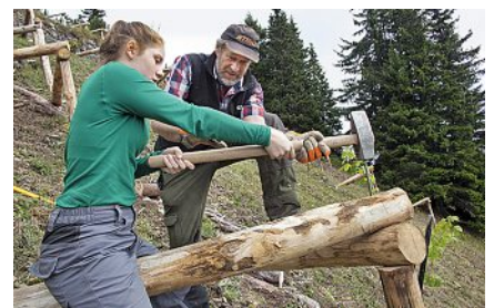
Installation von Ogiböcken: Dank dem engagierten Einsatz der Sekundarklasse 3B aus Embrach ZH wird an diesem Steilhang schon bald ein Schutzwald spriessen. Fotos: Roger Wehrli
